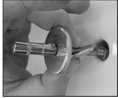
02 Inserire fissaggio nel foro del WC. Insert the screw in the appropriate hole.
